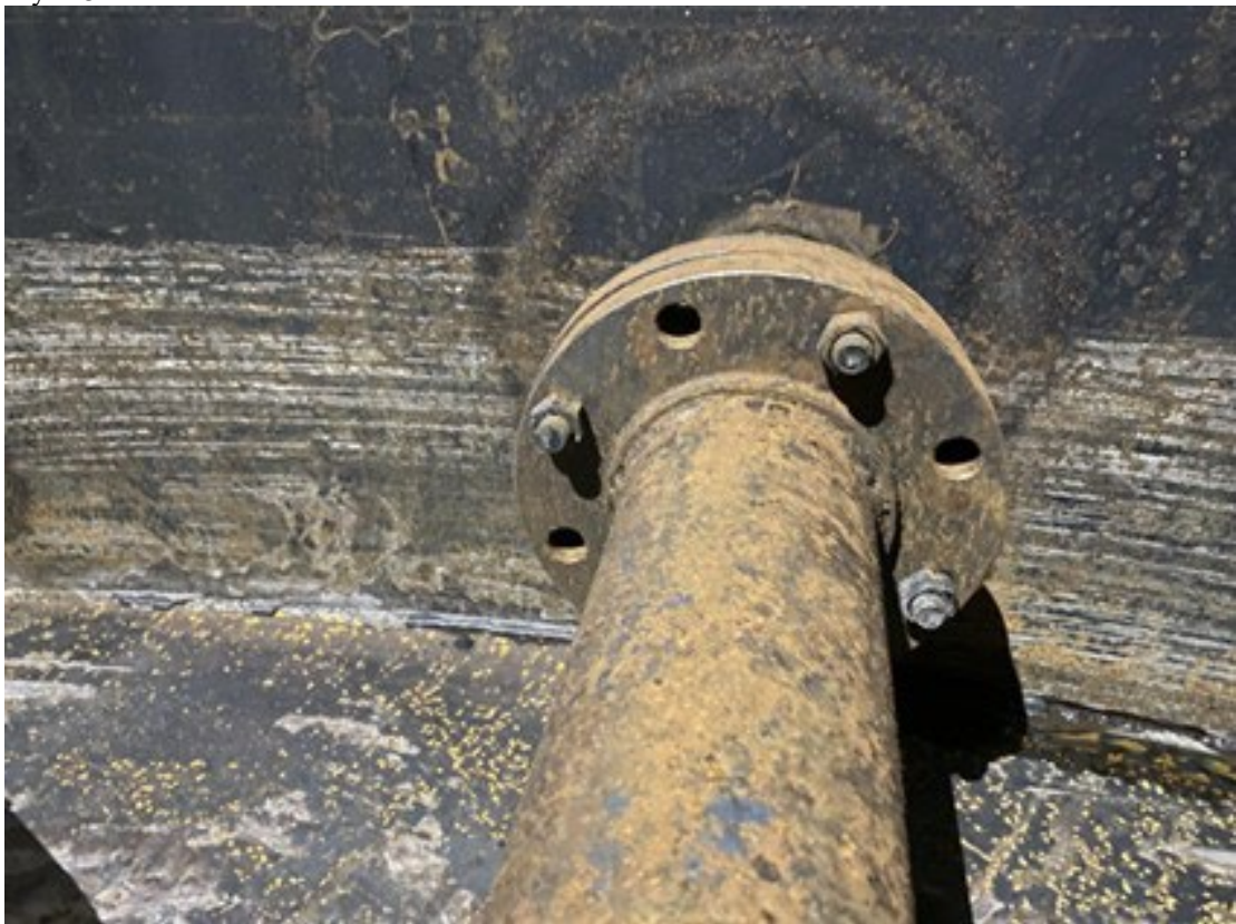
Mynd 4. Ekki voru allir boltar í flans.
